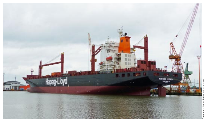
Zu den Investitionsschwerpunkten des Bremer Senats gehört auch die Sanierung der Kaje an der Lloyd Werft.
